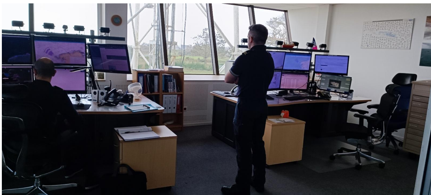
La salle de surveillance du rail
