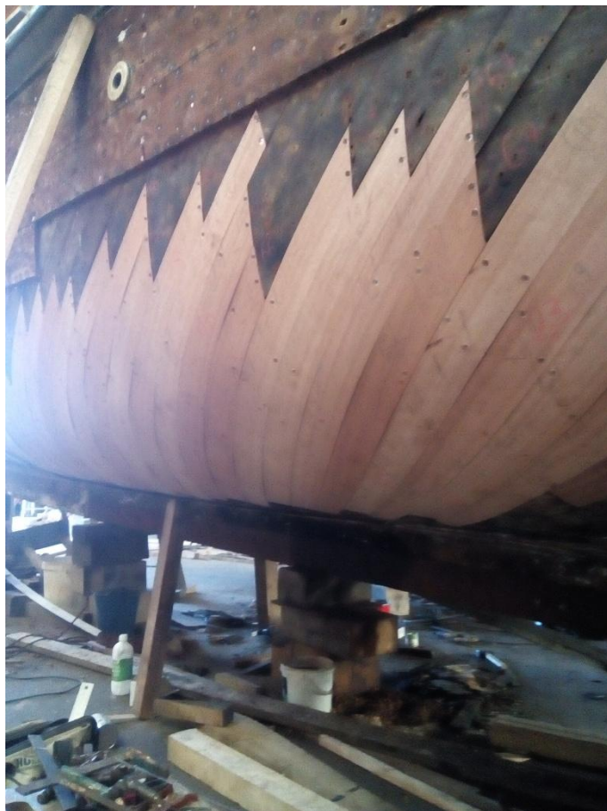
Les bordés abimés sont démontés puis la première couche de bordés intérieurs à 45° est refaite
