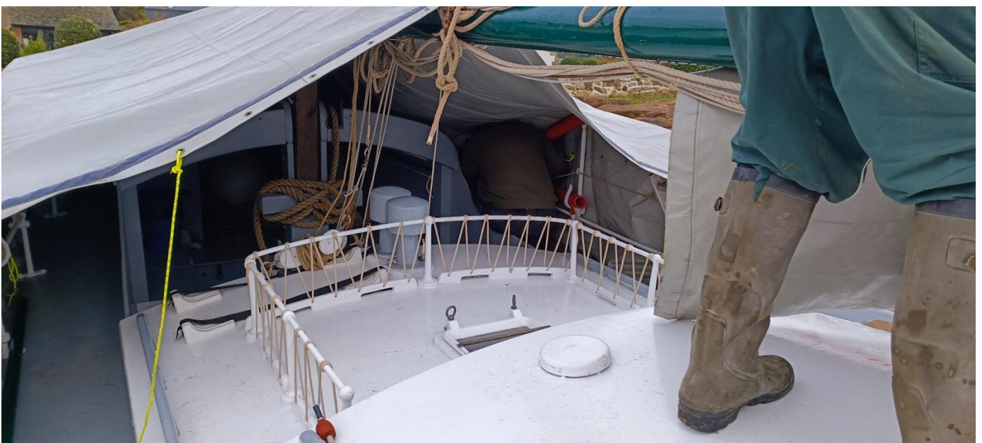
La partie avant est en place.
