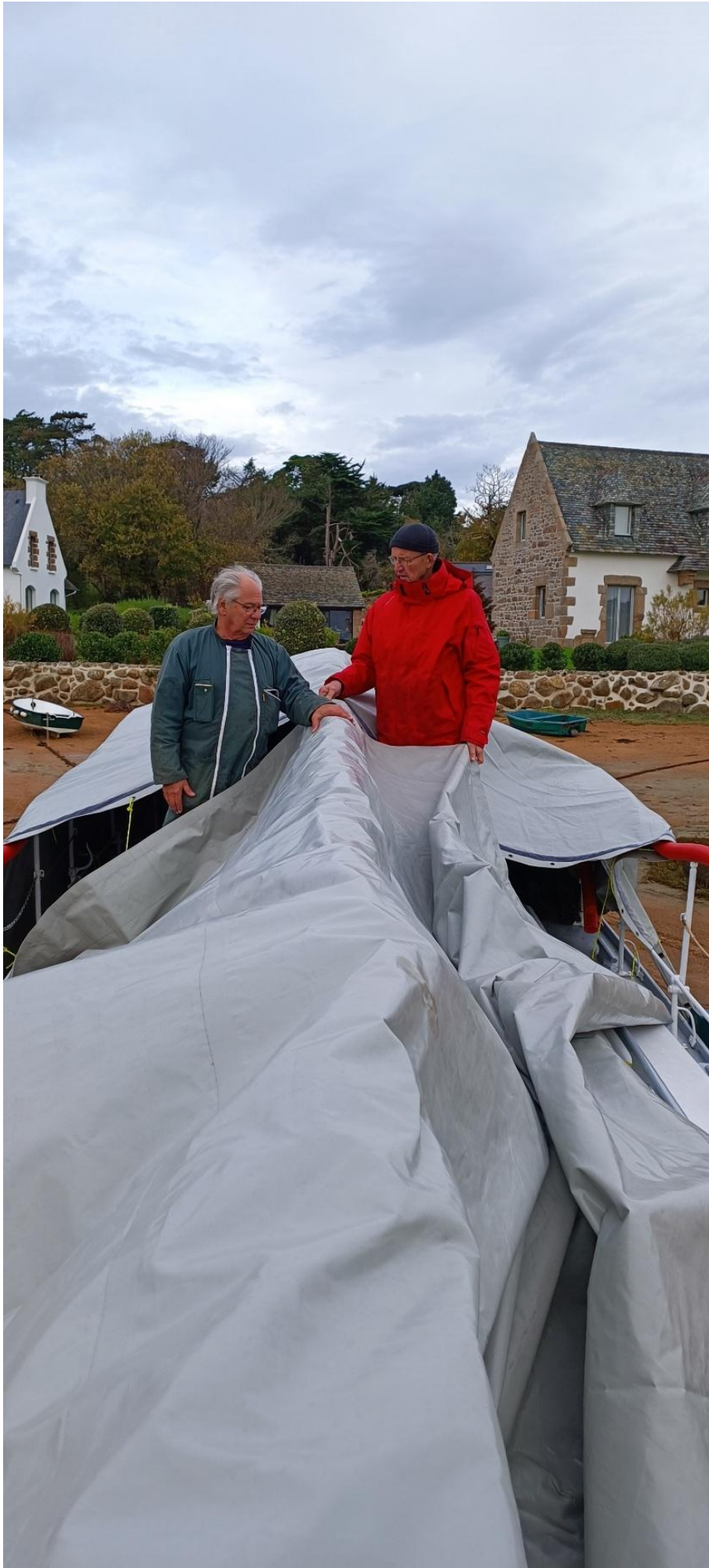
Mise en place de la partie arrière.
